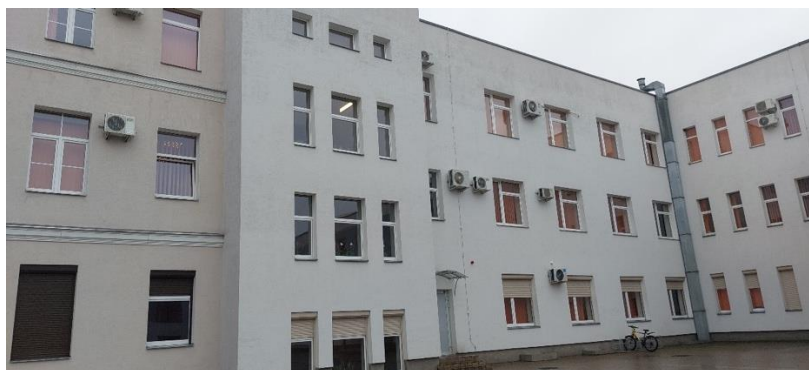
3.21.1. att. Visas ēkas ir renovētas. Vairākās telpās redzami uzstādīti kondicionieri.
