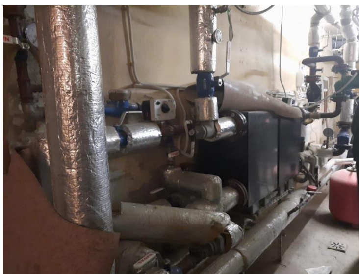
3.3.1. att. Ēkai ir divi siltummezgli, kas daļēji renovēti.
