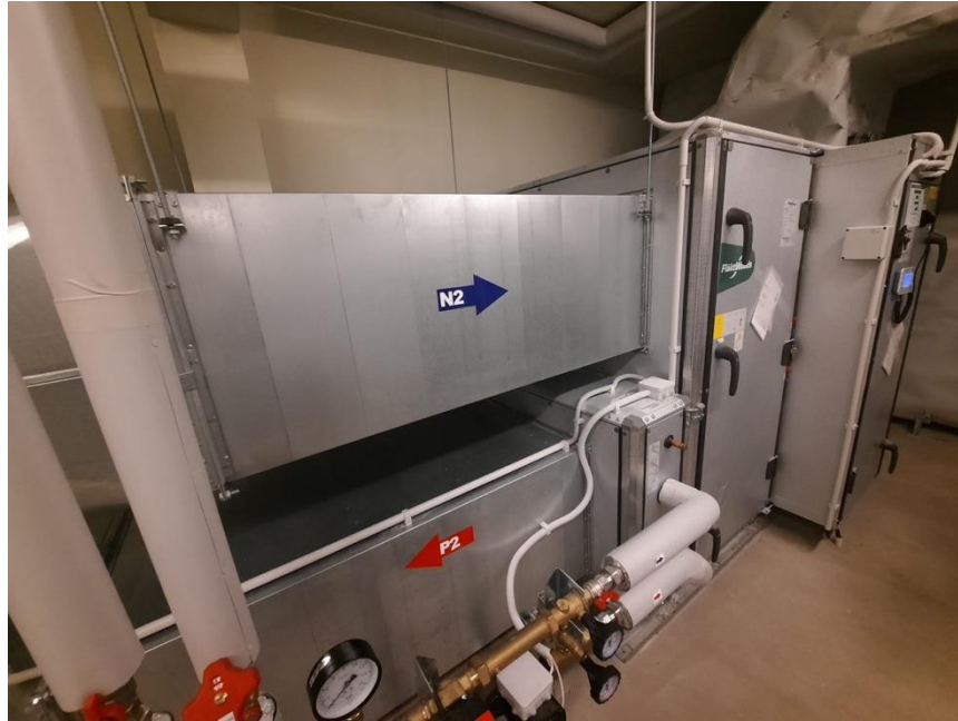
3.4.4. att. Ēkās darbojas vairākas ventilācijas iekārtas ar rekuperācijas sistēmu. Uzstādīti automātiskie darbināšanas režīmi.
