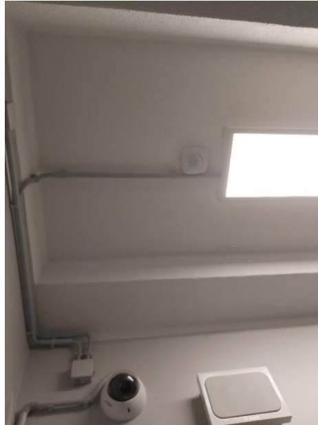
3.8.5. att. LED apgaismojums ar kustību sensoru.
