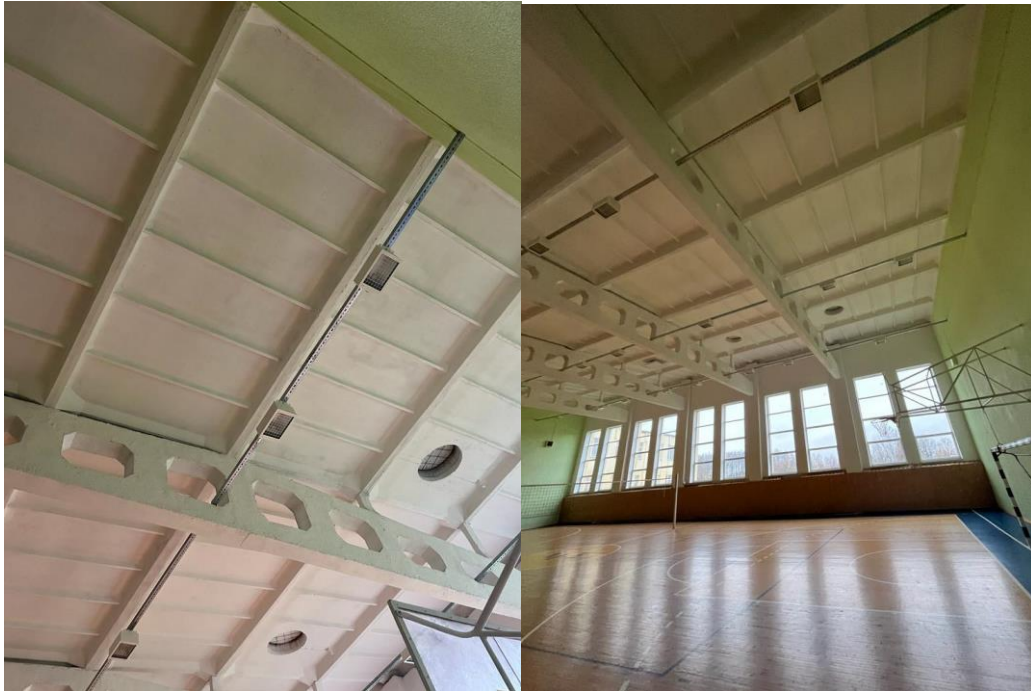
3.6.10. att. Sporta zāle ēkas nerenovētajā korpusā.
