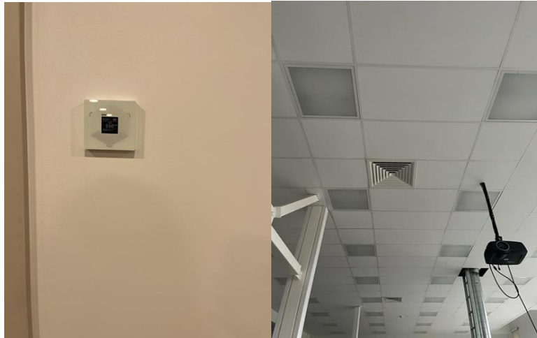
3.9.4. att. CO 2 mēritājs klasē (pa kreisi) un ventilācijas sistēma klasē (pa labi).
