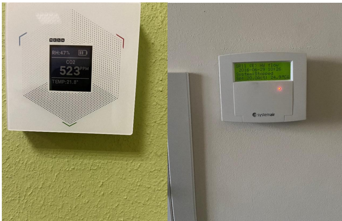
3.6.3. att. CO 2 mērītājs klases telpās (pa kreisi) un ventilācijas sistēmas kontroles panelis (pa labi).
