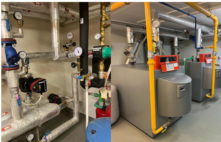
3.9.14. att. Katlumāja ar dabasgāzes katliem un apsaiستی dienesta viesnīcā (Aizupes, Tīnūžu pagasts).
