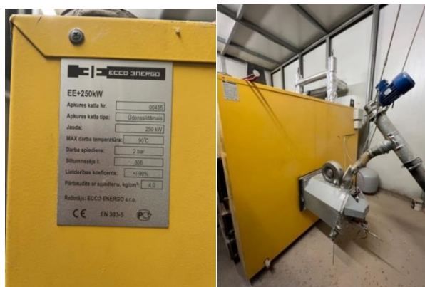
3.10.3. att. Granulu katla tehniskie parametri un granulu ražošana no kokmateriālu pārpalikumiem.
