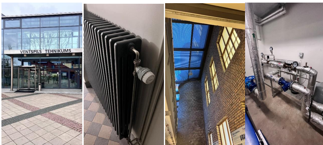
3.18.1. att. Ventspils tehnikuma galvenā ieeja, radiators ar regulatoru, ārtrijs un siltummezgls.
