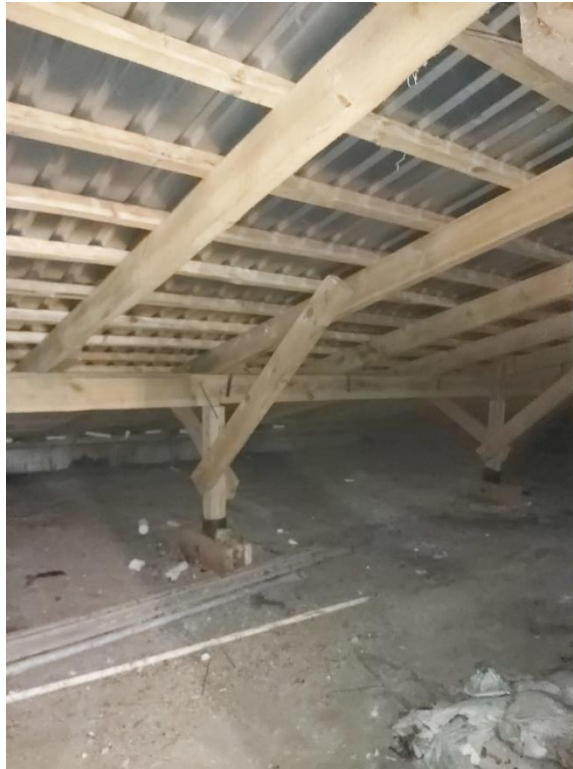
3.7.3. att. Jumta fragments Braslas ielā 16a pie ventilācijas sistēmas, nav siltināts.
