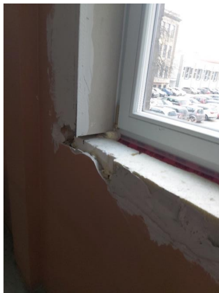
3.8.4. att. Logi no iekšpuses pēc montāžas darbu pabeigšanas, nav veikta ailu apdare.
