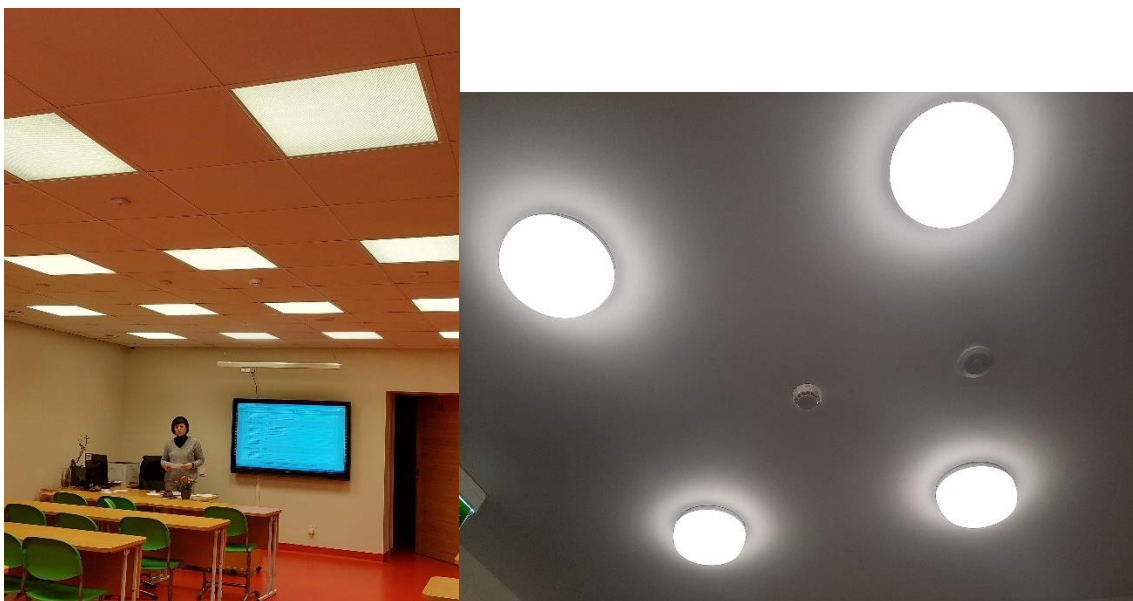
3.21.4.att. Galvenā mācību korpusa ēkās nomainīts apgaismojums.
