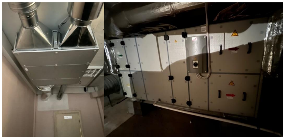
3.23.2. att. Mācību korpusā uzstādītas vietējās pieplūdes un nosūces iekārtas katrai klasei un sporta zāles ventilācijas iekārta.
