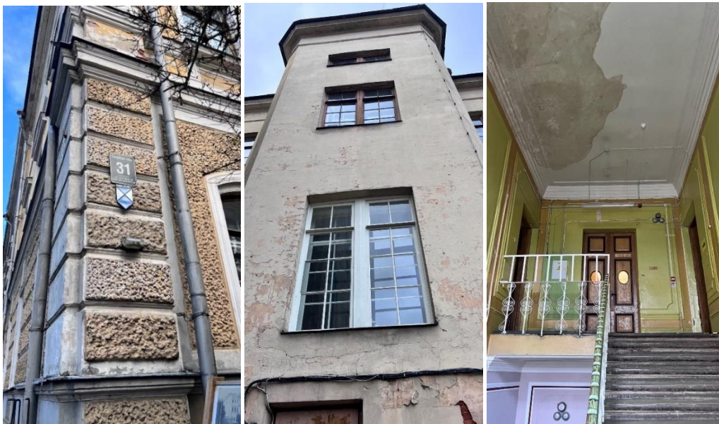
3.15.1. att. Kuldīgas Tehnoloģiju un tūrisma tehnikuma ēkas ir kultūrvēsturiskais piemineklis, tāpēc energoefektivitātes paaugstināšanai jāizvērtē siltināšana no iekšpuses.
