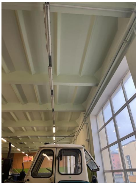
3.6.8. att. Vietējā gaisa nosūces iekārta galdniecības darbnīcā.
