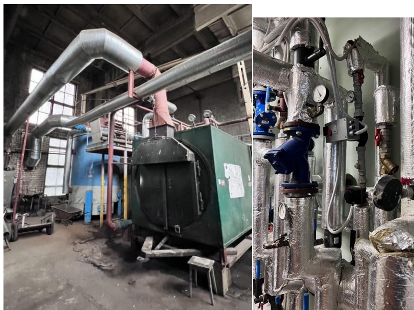
3.14.2. att. Kandavas Lauksaimniecības tehnikuma katlumāja un siltummezgls.
