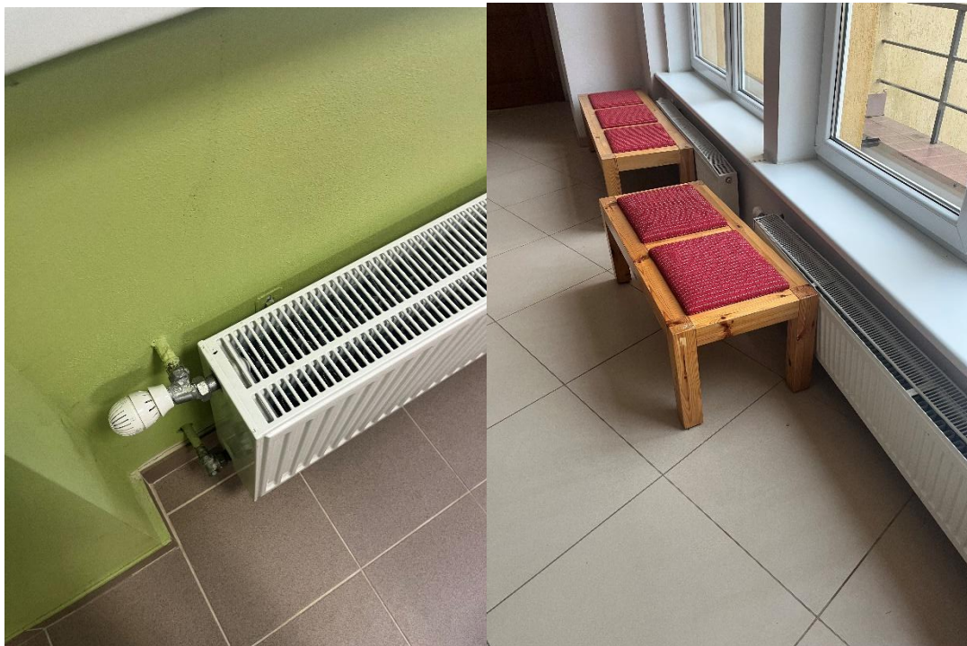
3.6.2. att. Sildķermeņi ēkas renovētajā daļā.
