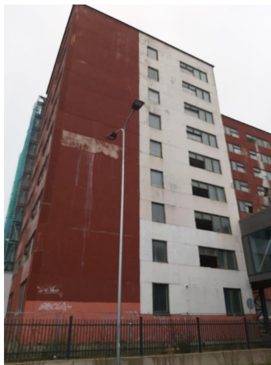
3.5.1. att. A. Deglava ielā 41a esošajā dienesta viesnīcā notiek rekonstrukcija.
